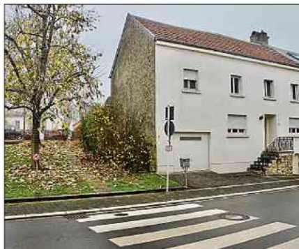
Der Abriss dieses Hauses ermöglicht die Vergrößerung des Parkplatzes „A Schungeschten“. Foto: André Feyereisen
